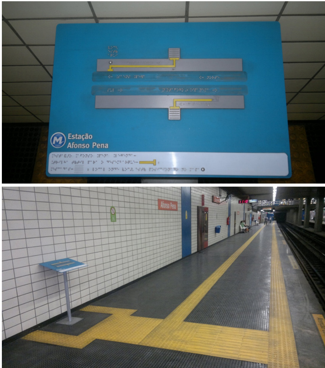
Figura 1 – Solução geoinformacional do metrô Rio para a orientação espacial de deficientes visuais
