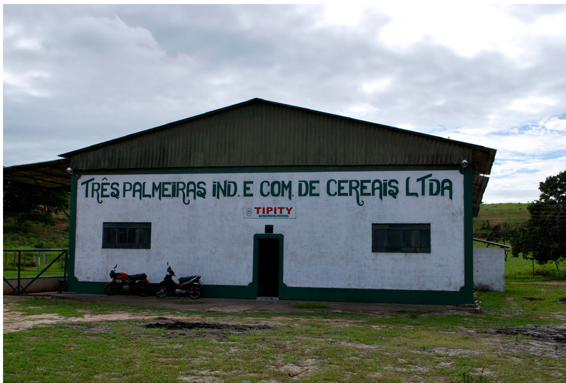
Figura 6 – Vista da atual fábrica mantida na região, remanescente da Tipity
