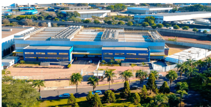
Data Center Campinas
