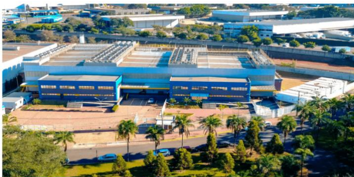
Data Center Campinas
