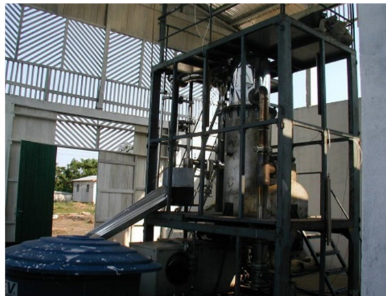
Foto 4 – Sistema de gaseificação para geração de eletricidade instalado em Aquidabam, município de Manacapuru, Amazonas
