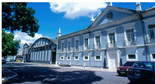
Fig. 16 - Imagem do Galpão (já demolido) anexo à casa das 11 janelas
