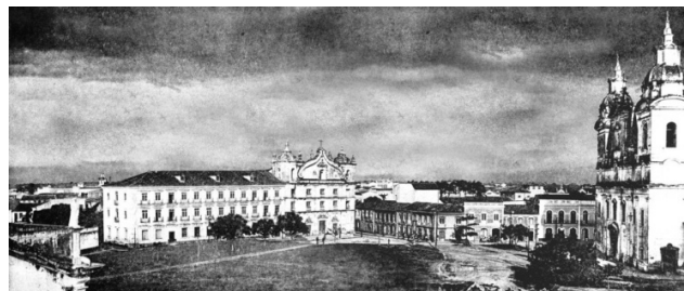
Fig. 13 - Vista da Praça Frei Caetano Brandão
