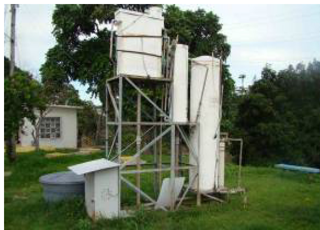
Figura 2 – Configuração final da ETA piloto Rio Negro
