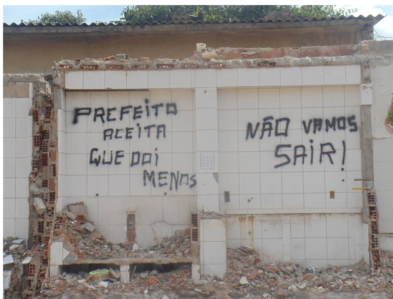
FIGURA 3 – Remoções. Recado para o prefeito nos escombros
