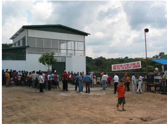
Foto 3 – Inauguração do sistema de geração de eletricidade em Aquidabam, município de Manacapuru, Amazonas
