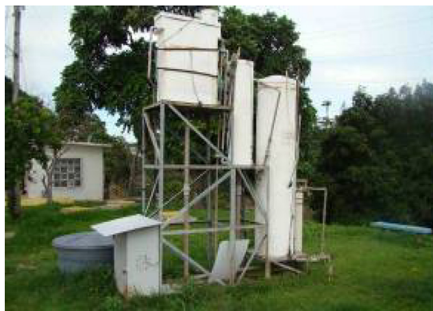
Figura 2 – Configuração final da ETA piloto Rio Negro
